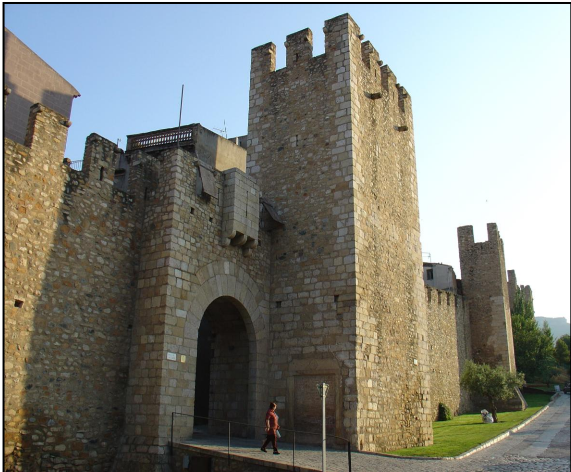
Portal de Saragossa. Montblanc
